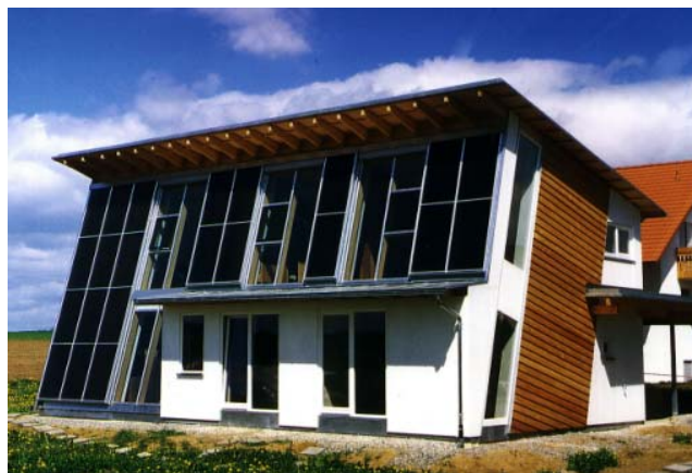
Fig. 1: Système solaire combiné avec capteur intégré en façade (Source: Wagner & Co, Allemagne)
